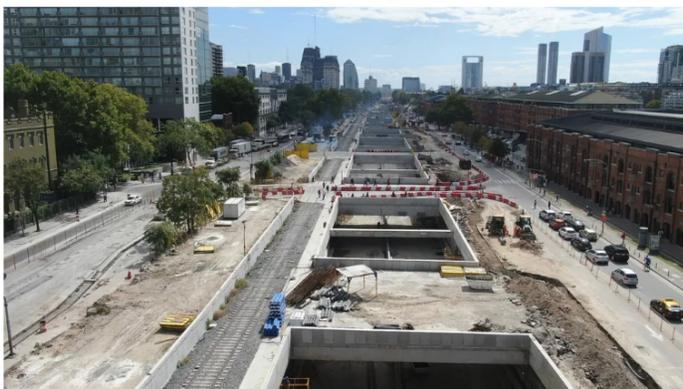
Los autos circularán al nivel de la calle, mientras que camiones y micros por viaductos y trincheras
