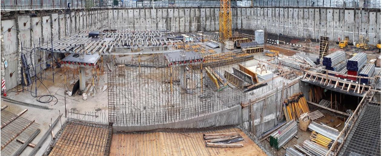
Vista desde sector de obradores hacia excavación. Se observa hormigonada parte de la losa sobre el 3SS y están realizando encofrados de parte de la losa sobre el 2SS.
