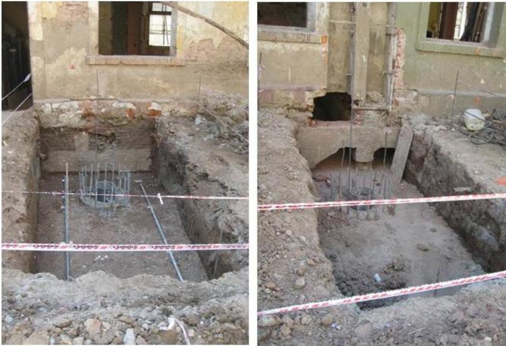
PILOTES EN SECTOR CASONAS
