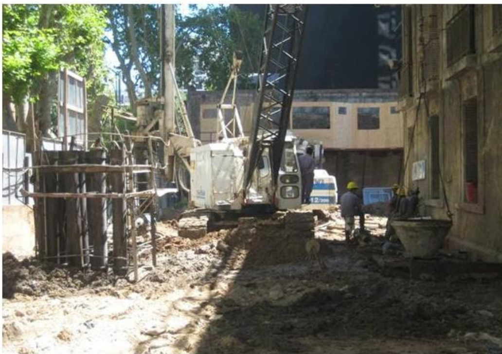
HINCADO Y HORMIGONADO DE LOS ULTIMOS PILOTES
