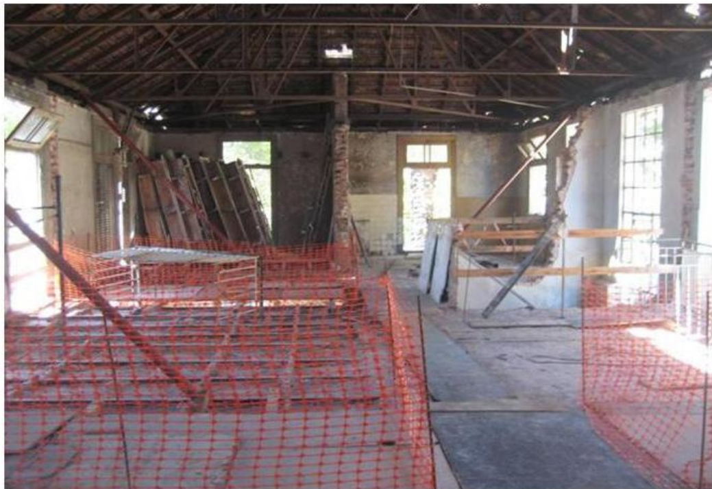
TAREAS DE APUNTALAMIENTO Y OBRA EN LAS CASONAS
