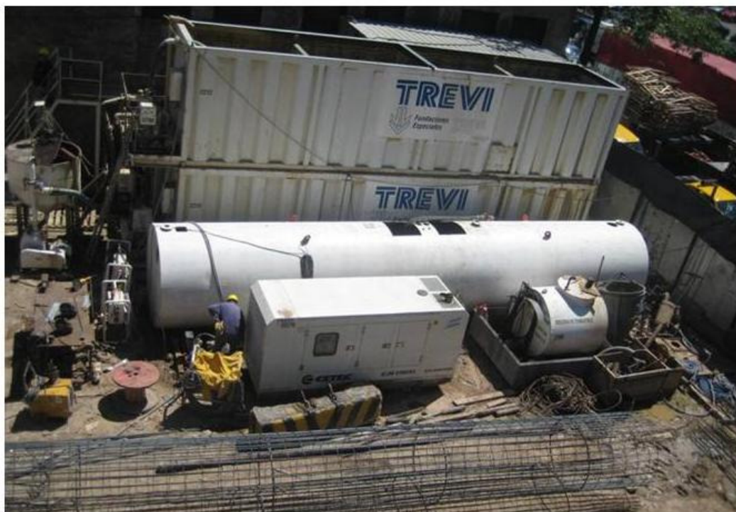
PLANTA DE HORMIGONADO DE PILOTES
