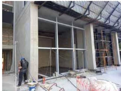
Colocación de carpintería de locales comerciales.
