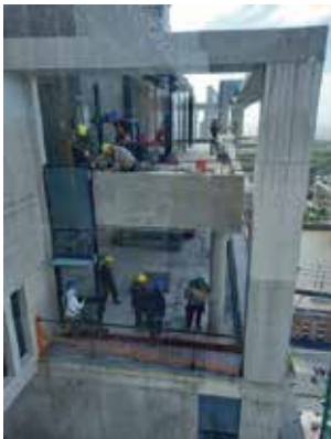
Torre 2: Iniciando la colocación del Frame en el sector Rio/Plaza.
