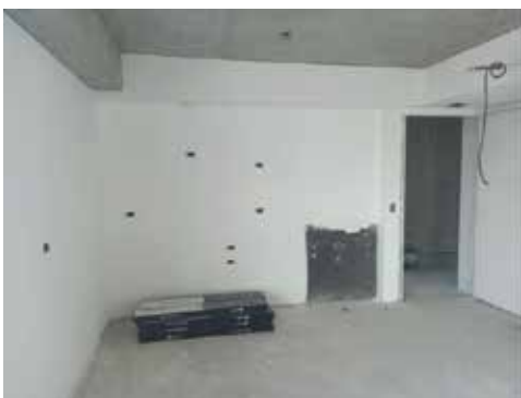
Torre 2: Primera mano de pintura en Piso 30°.
