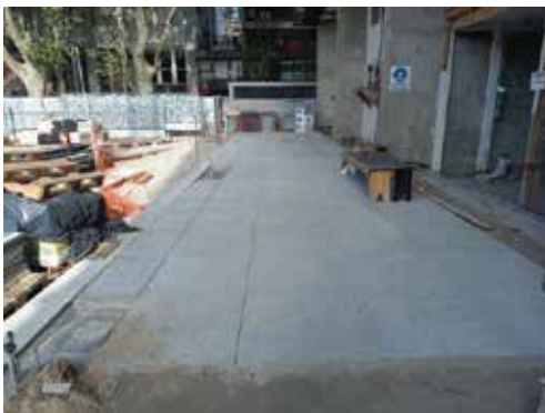
Comenzó la colocación del piso exterior en camino próximo a los loc. comerciales.
