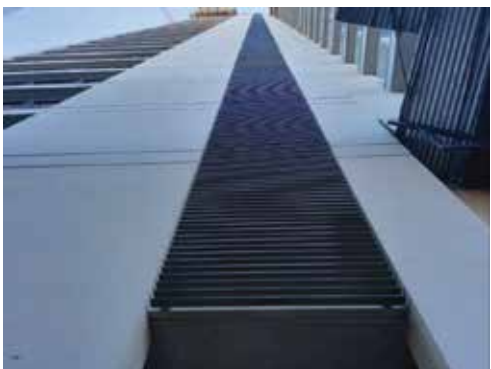
Avanza la colocación de las celosías, de los cerramientos ventilados.
