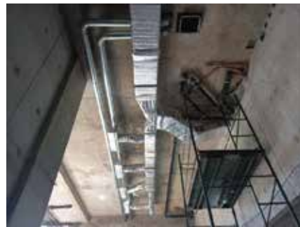
Iniciaron los trabajos de instalación termomecánica en Planta Baja.
