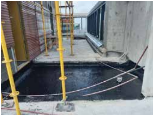
Torre 2: Revestimiento metálico en el Piso 36°, se continua con la Impermeabilización.
