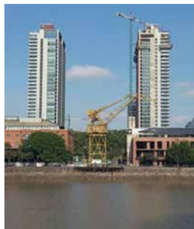
Vista de la obra desde Puerto Madero
