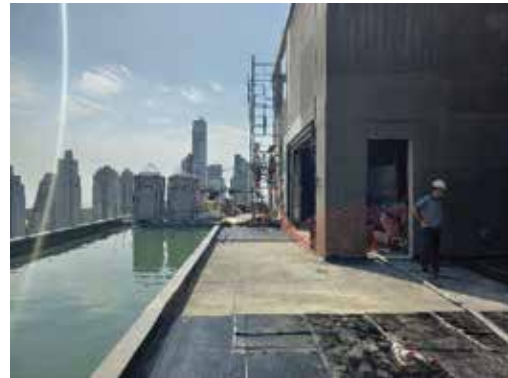
Torre 2: Avanza la impermeabilización
