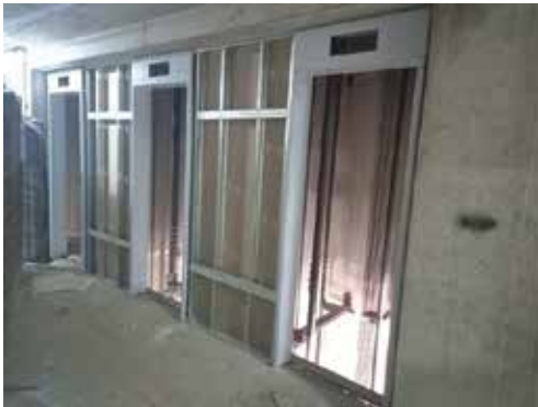
Colocación de marcos de ascensores y cierre de durlock en piso 2°
