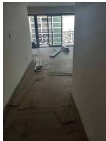
Torre 2: Colocación de piso vinílico Piso 29°.
