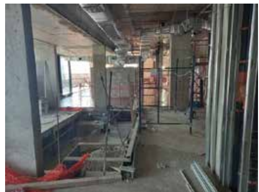
Torre 2: Avanzan las instalaciones en el sector del jacuzzi, Piso 36° Amenities.
