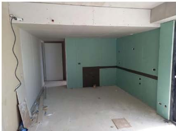
Emplacado de cielorraso y 2da placa en Piso 27°
