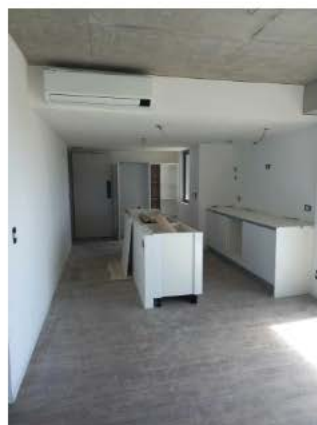
Colocando muebles de cocina en Piso 21°
