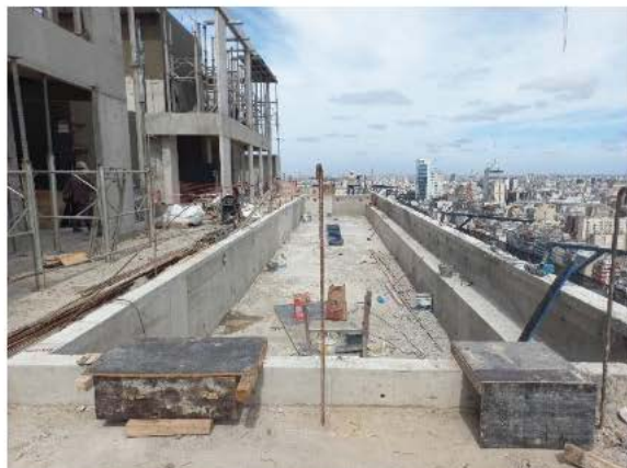
Se finalizó el hormigon de la Torre 2
