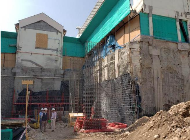
Armaduras de muros perimetrales.
