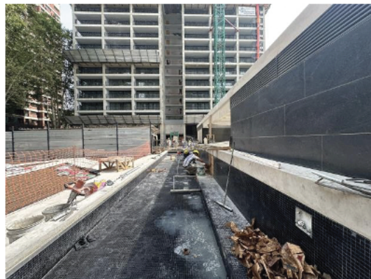
Colocación de revestimientos en fuentes en la plaza central
