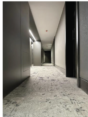
Torre 1: Iniciaron la colocación de alfombras en el piso 2° sector palier principal
