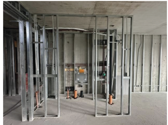
Torre 2: Instalaciones sanitarias y eléctricas piso 11
