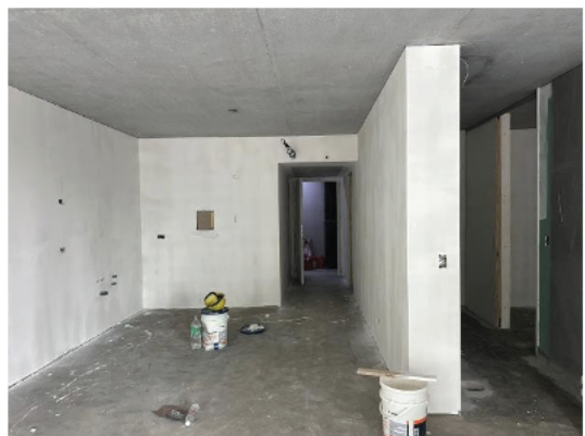
Torre 2: Enduido y 1° mano de pintura en piso 4°
