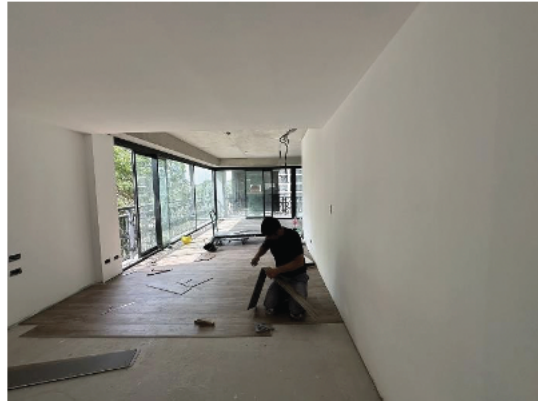
Torre 2: Avance de pisos vinílicos en el 3° Piso
