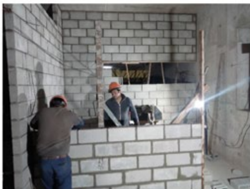
Elevación bloque de hormigón en subsuelos para salas técnicas.
