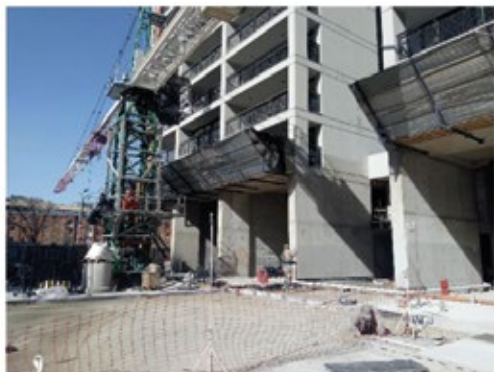
Retiro de todos los tramos de la Torregrua. Se aguarda por el desarme total.
