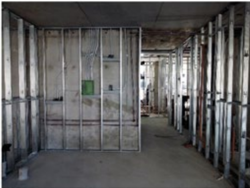
Se comenzó con las instalación sanitarias y eléctricas en piso 2
