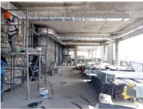
Aminities sector gimnasio, colocando los conductos de aire.
