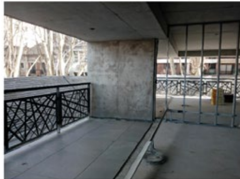
Inicio de los trabajos de pisos de porcelanato en balcones, Piso 2
