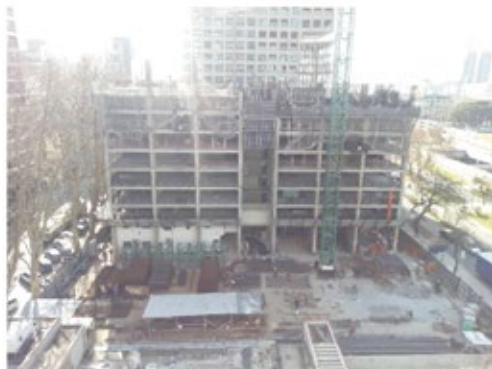
Vista desde la Torre1
