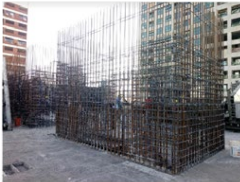
Armadura de núcleo de ascensores y escalera sector Río s/8 pisos
