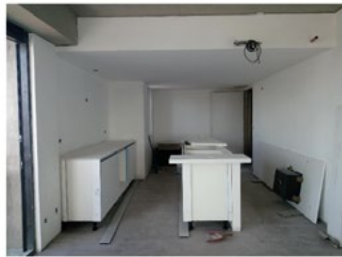
Colocación de muebles de cocina y mesadas en piso 30
