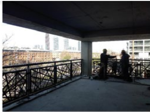
Colocación de barandas de hierro en piso 4
