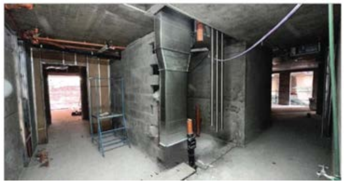
■ Instalación Ventilación Torre
