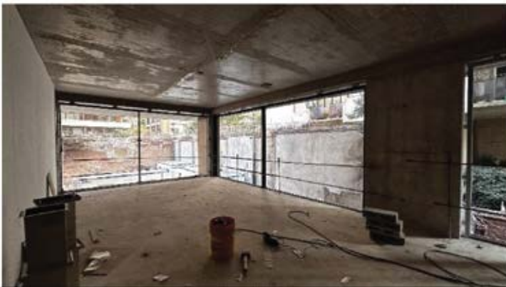
■ Carpinterías Montaje Marcos 1er Piso
