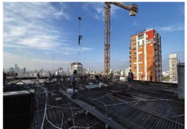
■ S/14P Encofrado y Armadura
