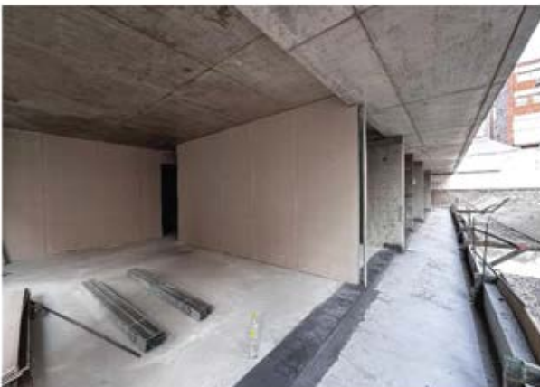
■ Tabiquería Durlock 1er emplacado
