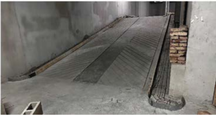
■ Rampas Vehiculares Subsuelos
