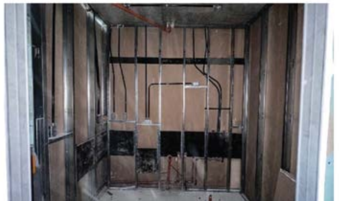
■ Instalación Eléctrica en Tabiquería Durlock
