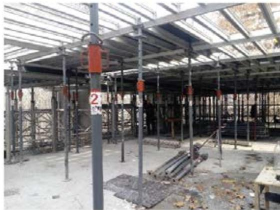
Armado de encofrado para losa s/6 piso sector Ciudad
