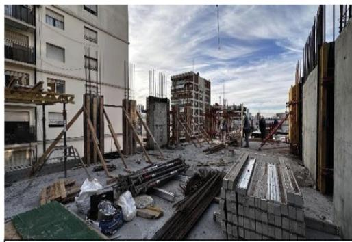
Encofrado/armadura/inst eléctrica losa s/11 piso
