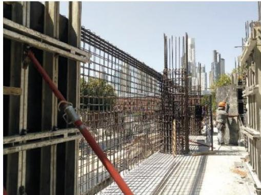
Armadura de Viga/pared en 1er piso
