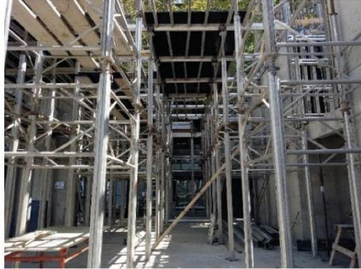
Encofrado de losa s/PB doble nivel
