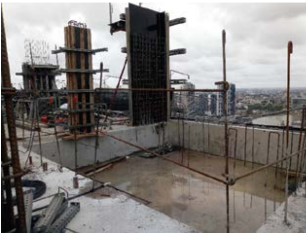
Hormigonado sector Hidromasajes en el piso 35 que une las dos semitorres.
