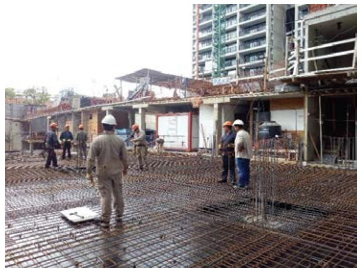
Armado de losa s/ ISS en sector central.
