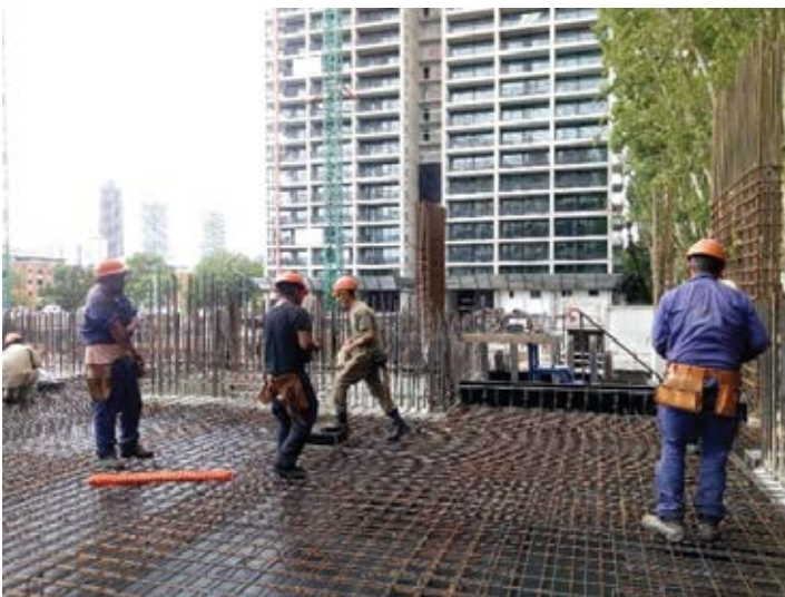
Armado de losa s/Pb en Torre2.
