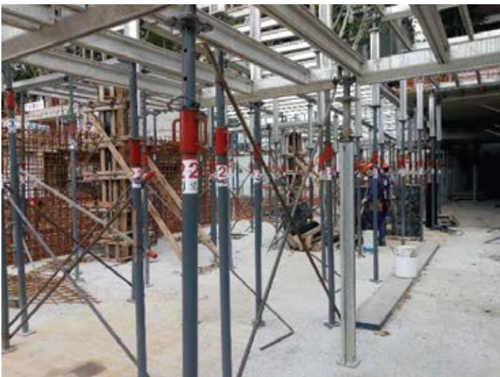
Encofrado de losa s/ Planta baja
