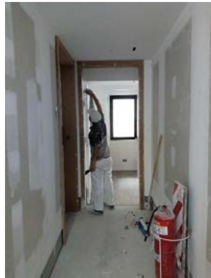
Colocación de marcos en puerta de palier y ultima mano de pintura en deptos. Piso 2
