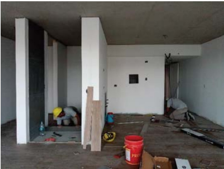
Colocación de piso vinílico en piso 21.
