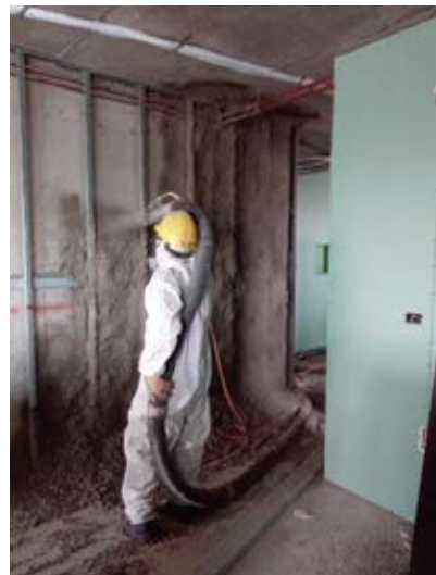
Proyectado de aislación celulosa sobre tabique en piso 27.
