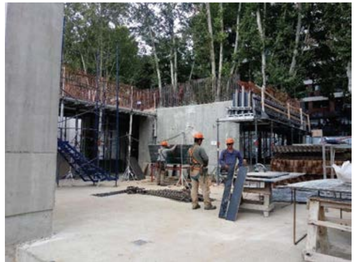
Armado de vigas y tabiques s/ Planta baja.
