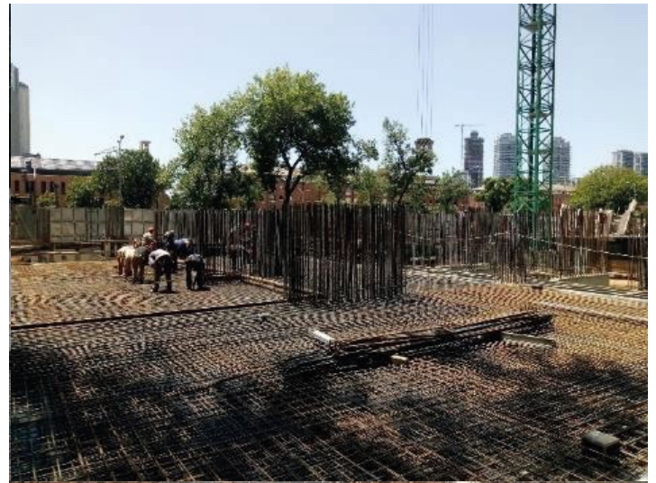
Armadura de losa s/ISS sector central lado México.
