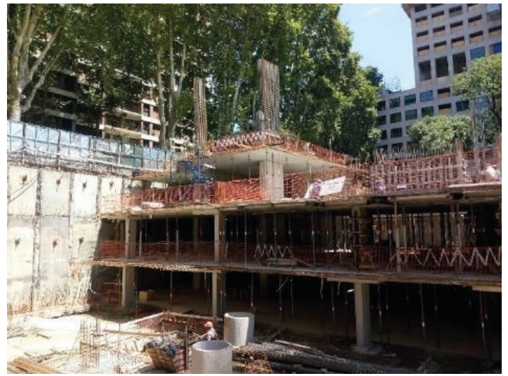
Se puede ver el avance de los 3 SS y las armaduras de las columnas de planta baja.
