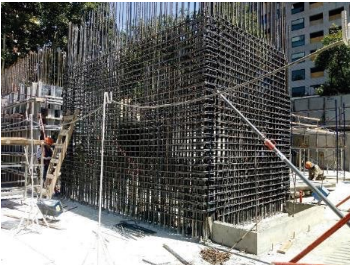
Armaduras de tabique s/ISS lado Río.
