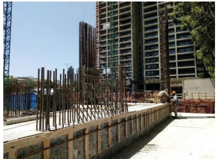
Hormigonado de pisada de Edificio lado Ciudad, y el armado de columnas s/PB.
