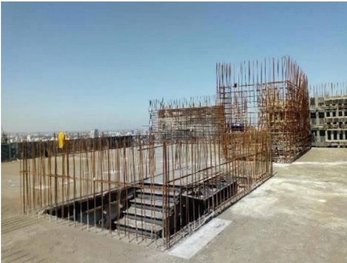
Hormigonada de losa s/33 sector Rio.
