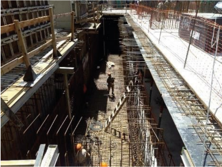
Armado de tanque de impulsión.
