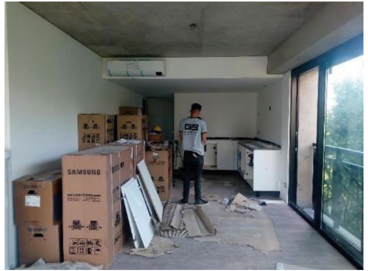
Colocación de muebles de cocina en piso 10.
