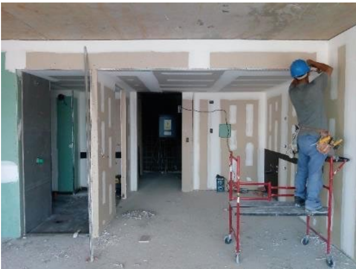
Armado de cielorraso de durlock en piso 23.
