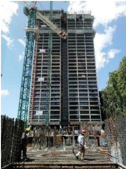
Sector central de la torre donde se puede observar la Torre1 y el armado de losas/ISS
