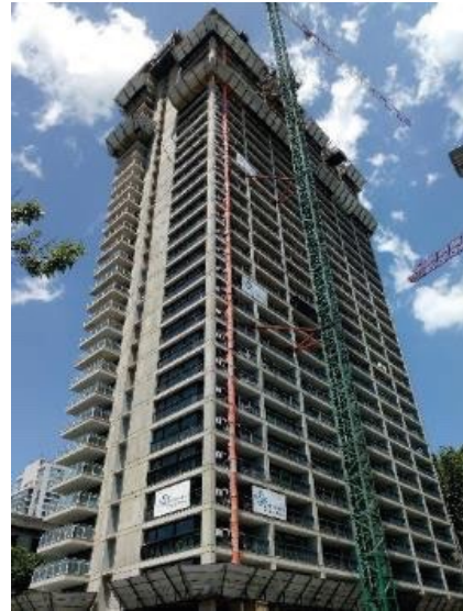
Vista De la obra desde Av. Huergo.
