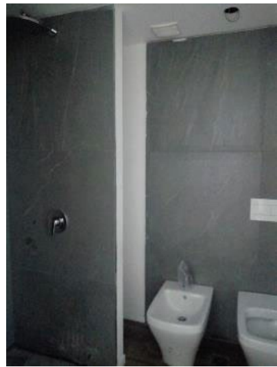
Colocación de artefactos sanitarios en piso 9.
