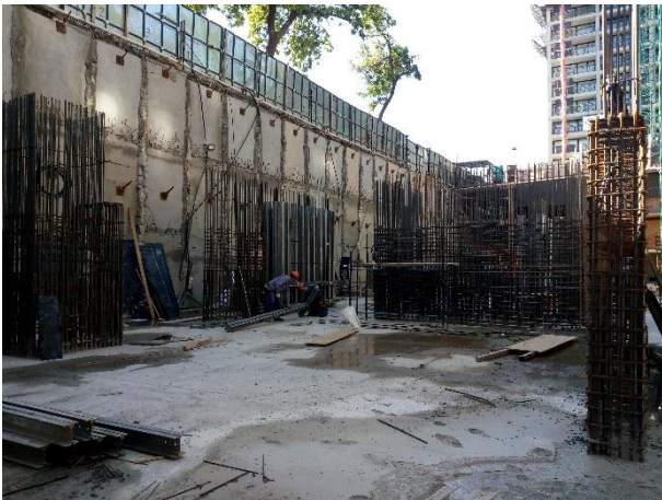
Armado de tabique y columnas s/3ss sector Huergo.
