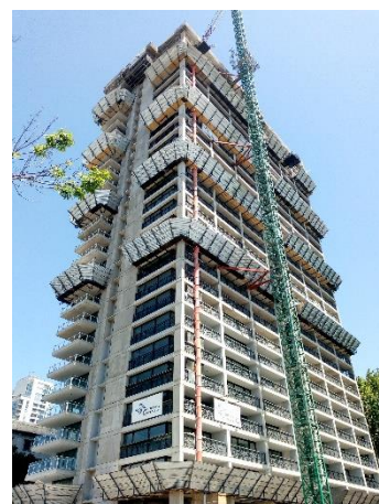
Vista de la obra desde la Av. Huergo.
