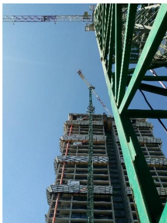
Se termino de instalar la grúa para la Torre 2.
