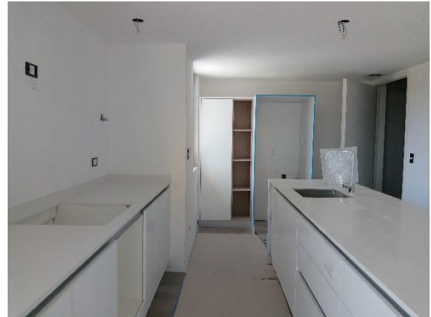
Se comenzaron a instalar los muebles y mesados de los departamentos unificados.
