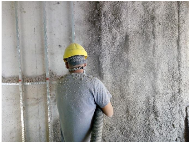
Proyección de aislación celulosa en los tabiques interiores en el piso 21.
