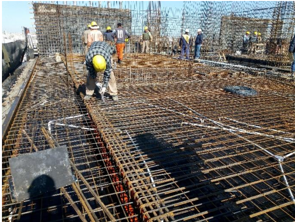
Armado de losa s/29 sector Río.
