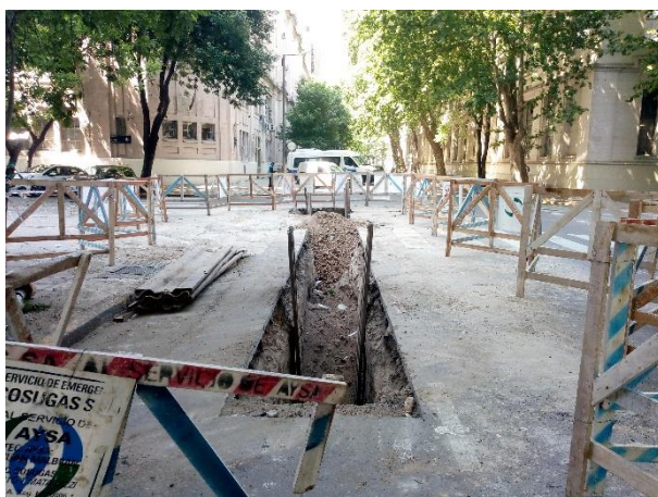
Se iniciaron los trabajos de obra externa de agua y cloaca sobre la calle Azopardo.
