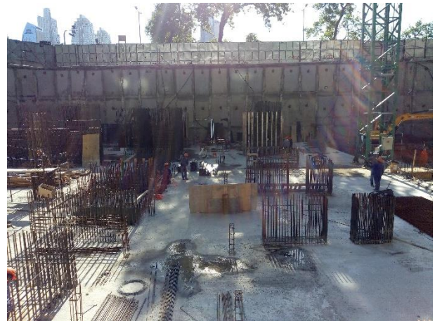
Se hormigonaron los bajos recorridos de los ascensores.
