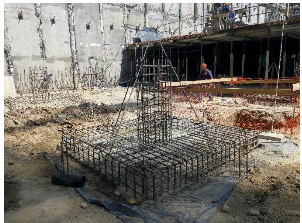
Se iniciaron los trabajos de las bases por fuera de la platea.
