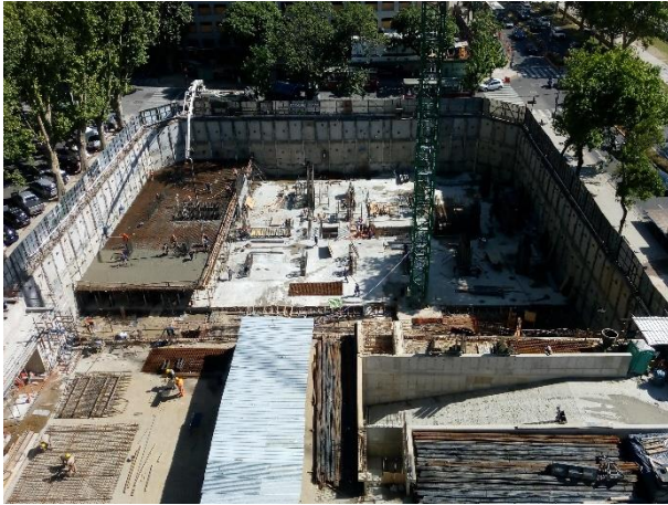
Vista aérea donde se puede observar la platea finalizada.
