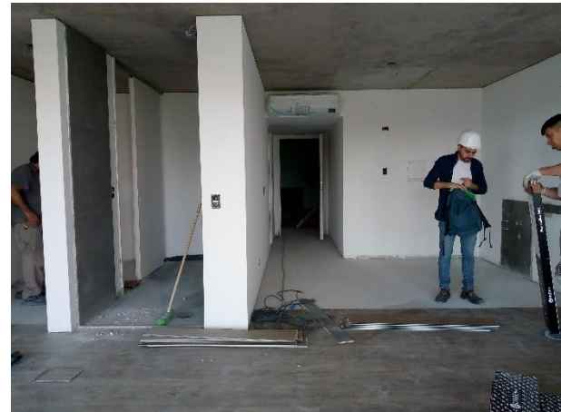
Colocación de piso vinílico en el piso 11.
