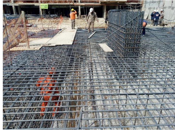
Se iniciaron la colocación hierros para las columnas y tabiques.
