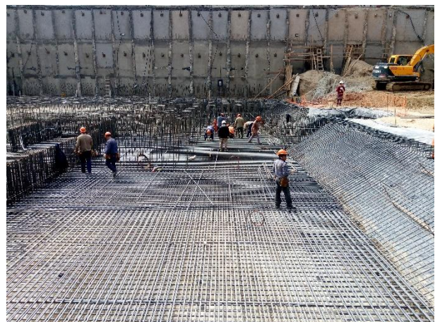
Platea sector lado plaza iniciando la primera capa de armadura.
