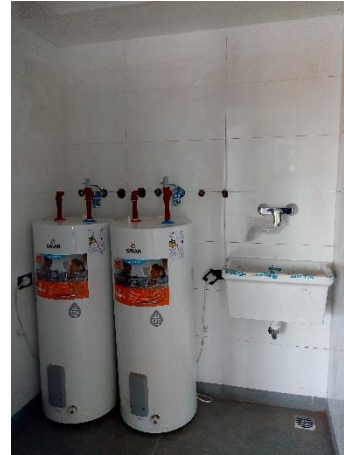
Colocación de termotanques en unidades Unificadas.
