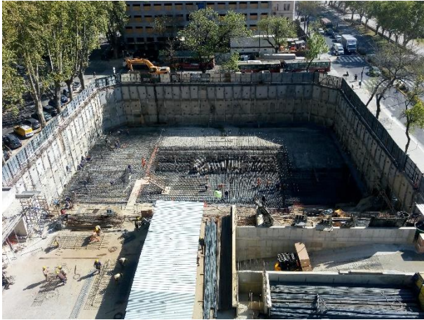
Vista aérea de la etapa 3ª del subsuelo de la torre 2.
