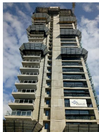
Vista de la obra desde Av Huergo.
