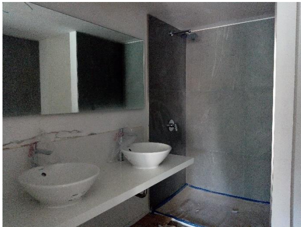
Continúan con la colocación de artefactos sanitarios en el 3er piso.
