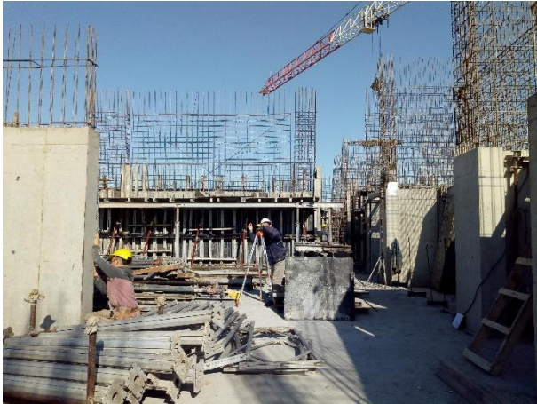
Iniciando los trabajos para la losa s/27.
