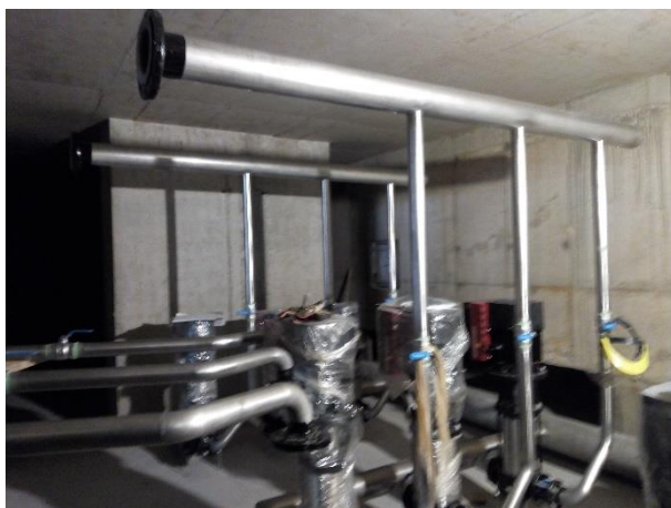
Se iniciaron los trabajos de armado de colectores en sala de máquina.
