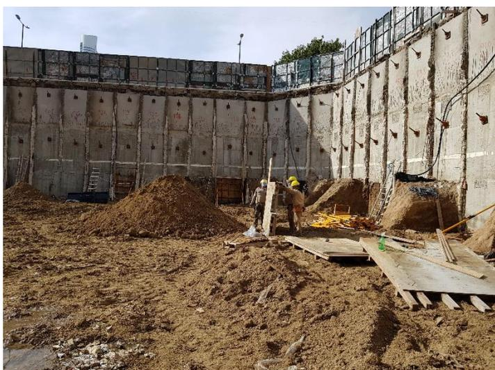
Preparado de encofrados para hormigonar (cada operario con los elementos de seguridad que solicita el protocolo)
