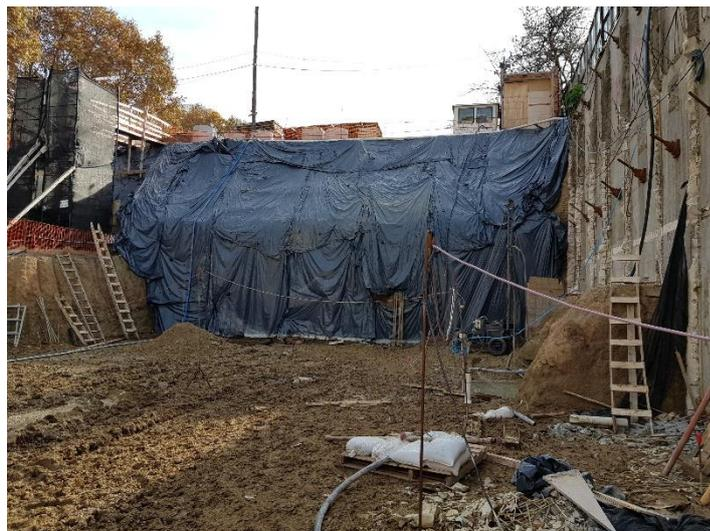
Acondicionamiento de protección del talud con nylon para mantener las condiciones de humedad.
