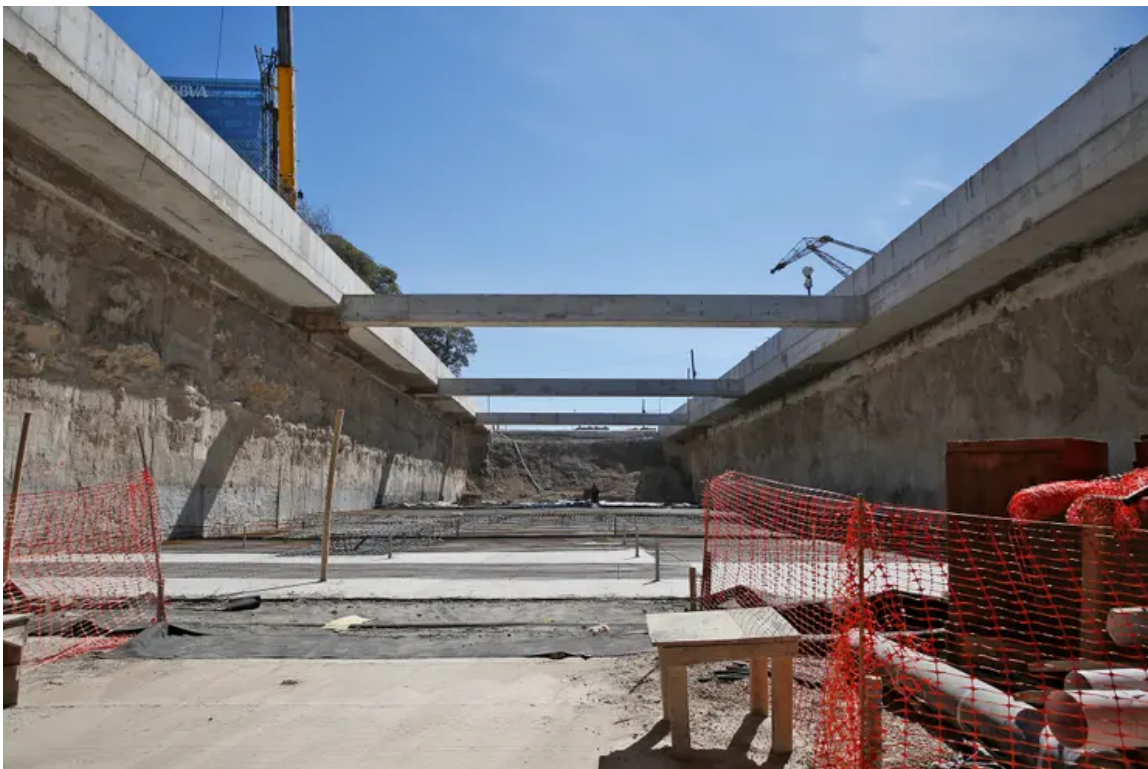
Avanzan las obras en el Paseo del Bajo
